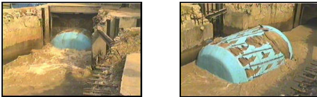
Fig 8.- Aspecto de la Caja de Enlace durante la llegada del dispositivo
