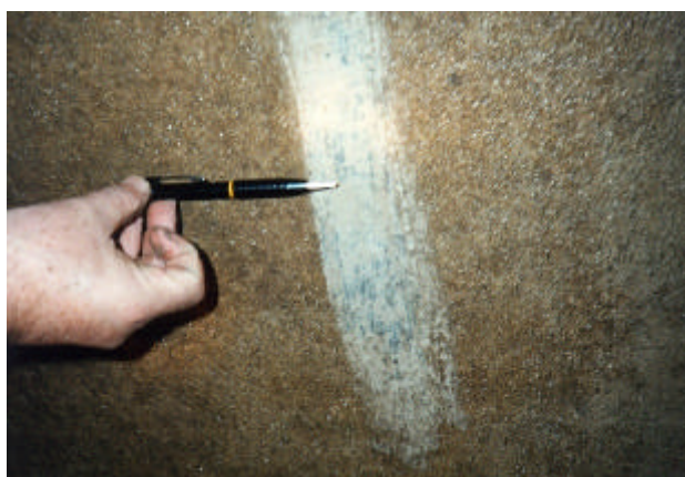
Fig 10.- Apariencia de la pared interior del acueducto, antes y después de la limpieza
