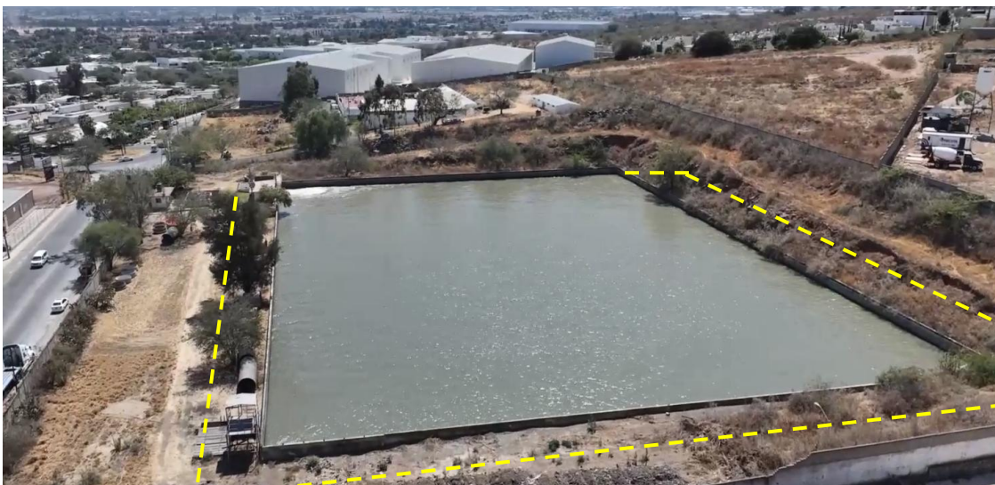
Figura 5.4 Vista Aérea del Tanque de Entrega y
