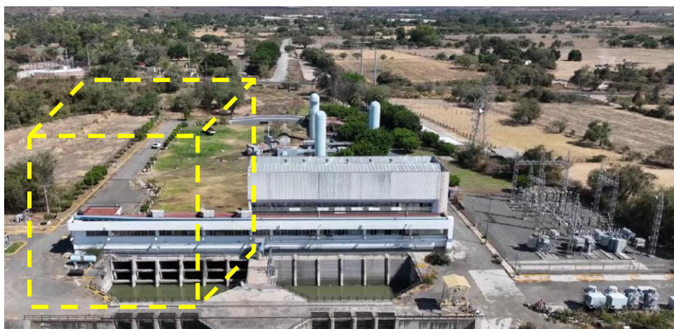
Figura 5.1 Vista Aérea de la estación de bombeo Chapala
