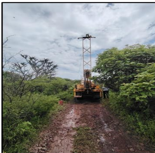
Figura 4.11 Fotografía del Sondeo 7C
