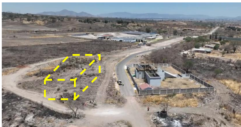
Figura 5.3 Vista Aérea del Tanque de Cambio de Régimen Existente
