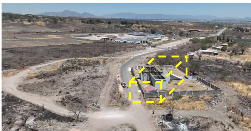
Ilustración 22 Vista aérea del tanque de cambio de régimen existente
