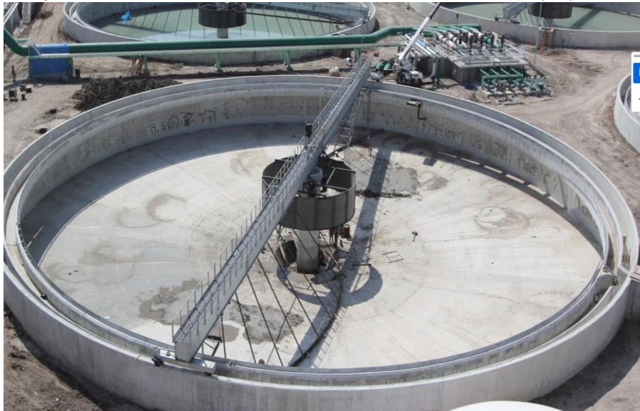
Figura 22. Clarificador Secundario, infraestructura similar a la propuesta
