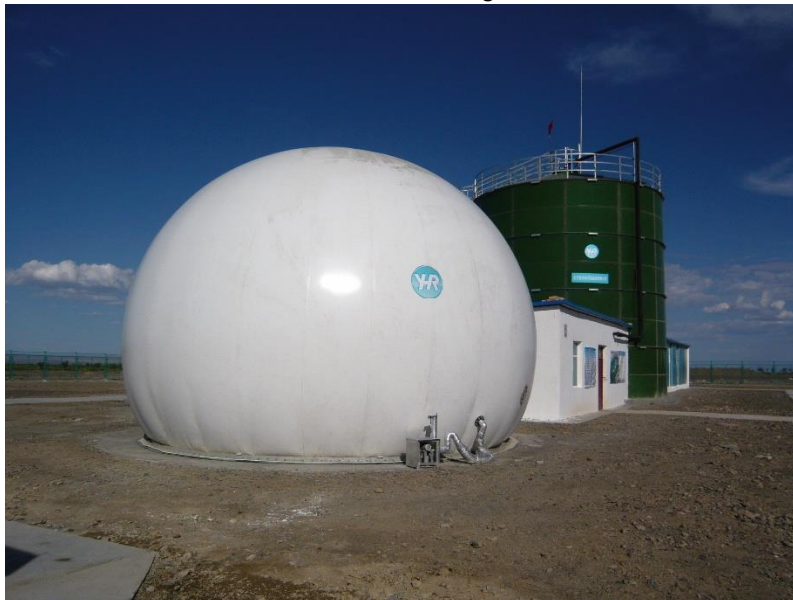
Figura21. Membrana dobla de almacenamiento de biogás, infraestructura similar a la propuesta
